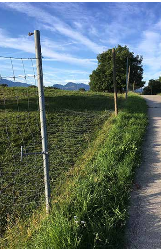
Mehrere Zäune wurden beschädigt. Plusieurs enclos ont été vandalisés. (Photo: Ph. Charrière)
