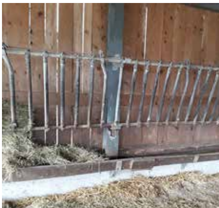
Als Raufe dient das ehemalige Fressgitter der Kühe. L'ancien cornadis à vaches sert de râtelier.
